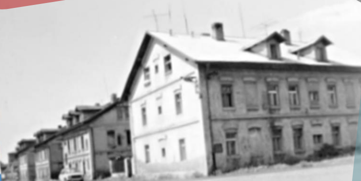
Kolonie (1963) – původní hornická kolonie
